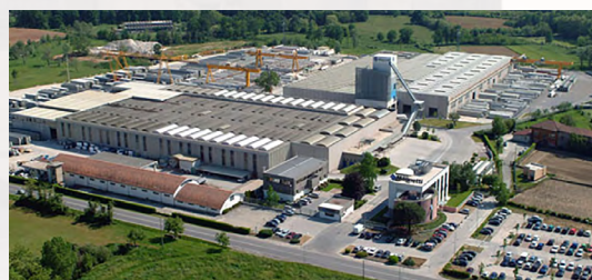
Impianto di prefabbricazione Magnetti Building
